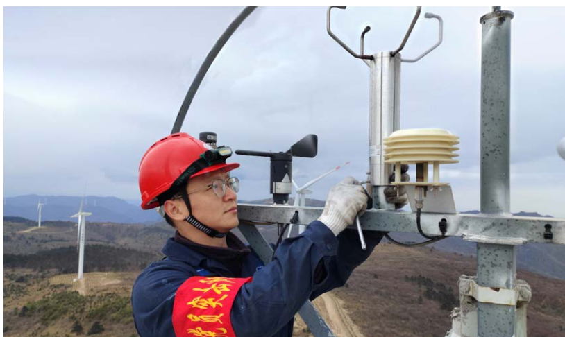
安装加热型超声波气象仪
