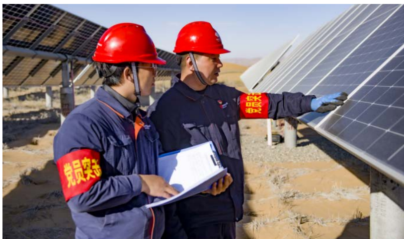
宁夏腾格里“沙戈荒”新能源基地中卫光伏项目党员技术骨干正在巡视光伏组件
