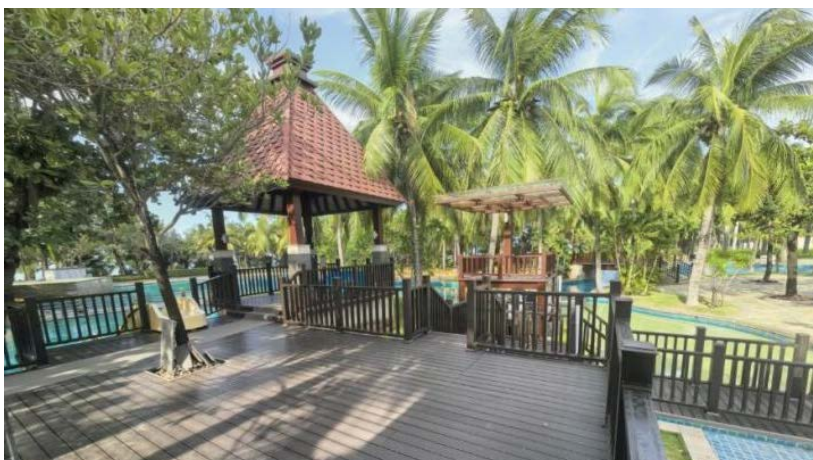
退役风机叶片回收再利用制成型材，用于酒店户外地板铺设
