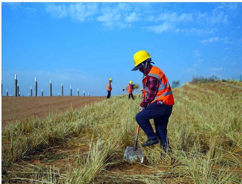
新能源项目建设同步实施草方格固沙生态修复
